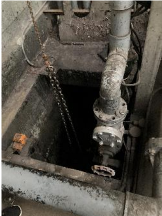
排水の最初の工程
