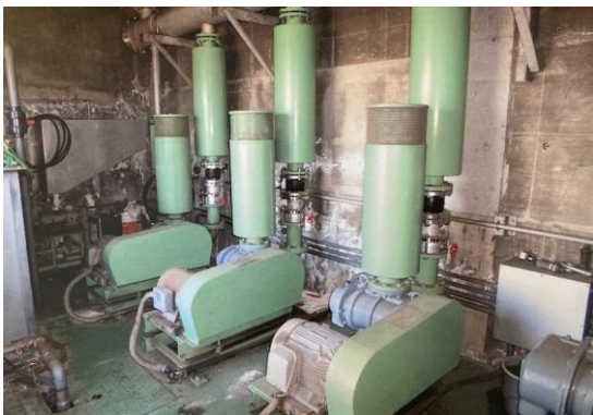
ブロー機を使って細かい空気を活性汚泥処理槽に送り込む（左）
