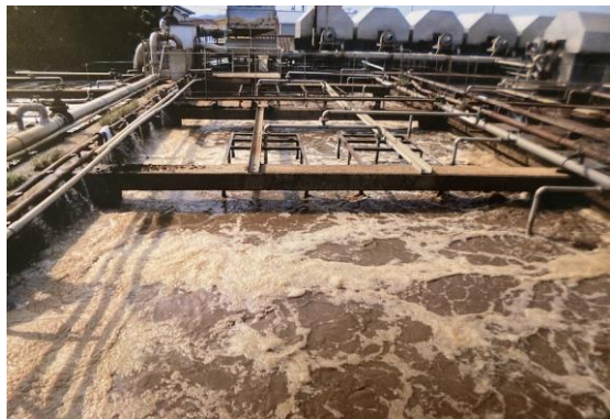
ブロー機を使って細かい空気を活性汚泥処理槽に送り込む（左）
