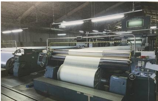
サイジング機2台を設置
